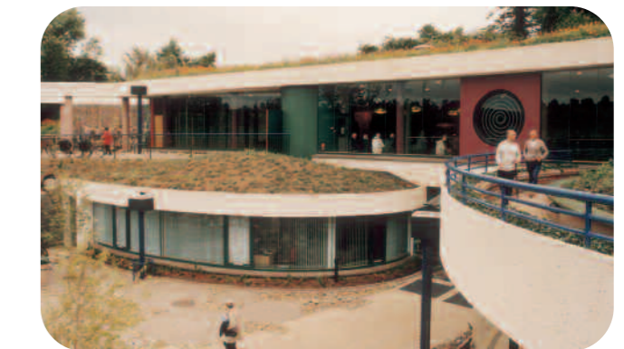
Das Besucherzentrum von Brú Na Bóinne
