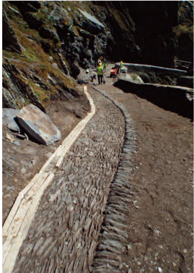
Pl. 31 Bóthar an Tí Solais Uachtaraigh, tar éis tochailte, a thaispeánann dromchla bunaidh an bhóthair, draenacha agus seoladán leictreach a cuireadh isteach go luath san fhichiú haois.
